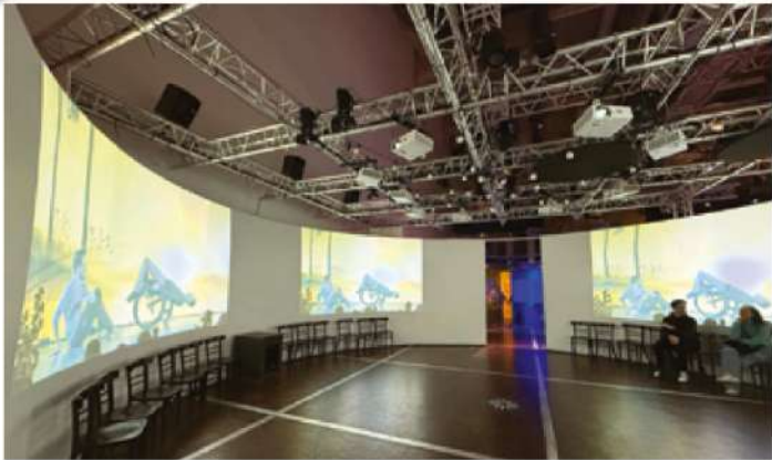
La piste de danse est surplombée de vidéoprojecteurs ViewSonic, associés à des enceintes Mackie et à des capteurs Kinect, permettant aux participants d'interagir avec les images projetées en périphérie.
